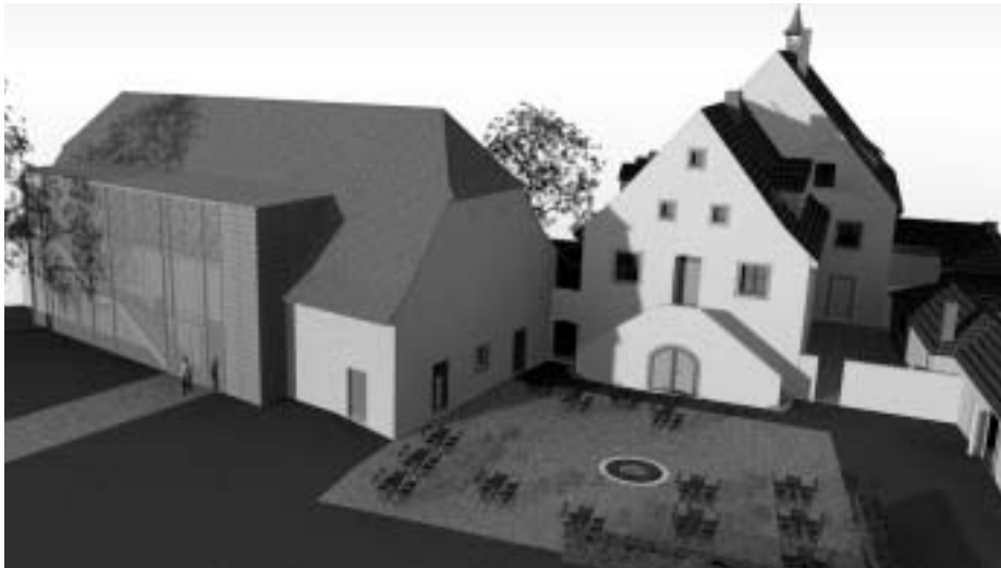
Das Stubenareal im Jahr 2019: Die Scheune (links), das Herzstück des Bürger- und Vereinshauses soll einen gläsernen Vorbau für Treppen und Fahrstuhl erhalten. Rechts im Bild entsteht zwischen Scheune und Hauptgebäude Platz für eine Außengastronomie.
